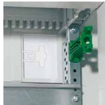
Встроенная гребенка для фиксации кабеля и большое пространство для монтажа
