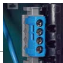
Клеммные колодки могут быть установлены сверху, снизу или сбоку.
